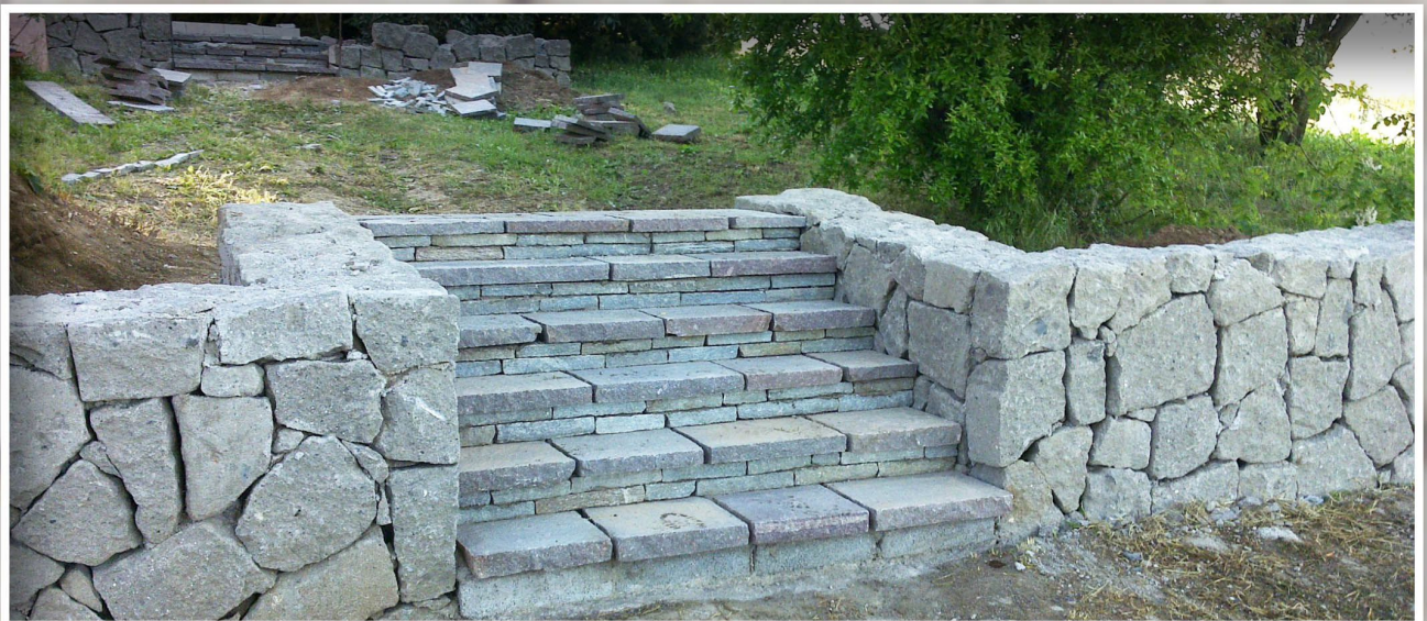
MURO IN PEPERINO
