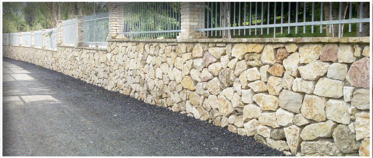
MURO IN PIETRA A SECCO
